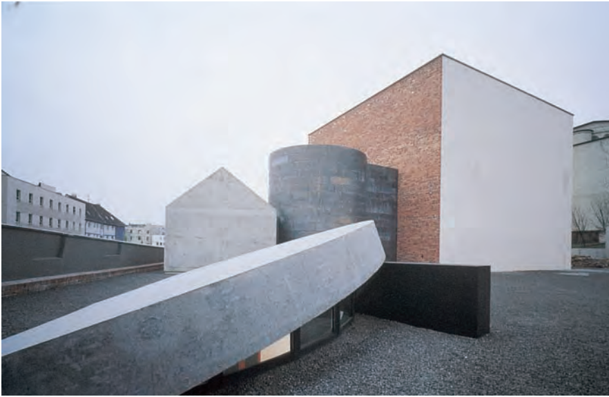
Begegnungsstätte Alte Synagoge in Wuppertal-Elberfeld
